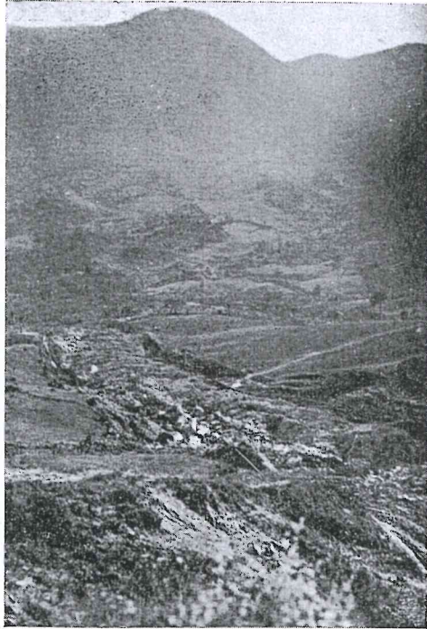
Frana N. 1 presa dall'alto in basso; di fronte al Monte dello Spicchiere
