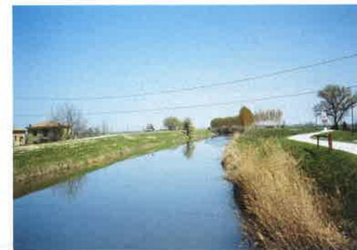
● Fig.12 Località Quattrina: Canale Diversivo di Burana corrispondente al secondo tratto del "Ramo della Lunga" tagliato alla fine del XIX secolo.
