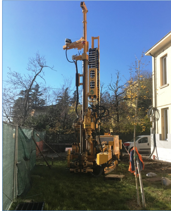
Posizionamento sondaggio DH-1
