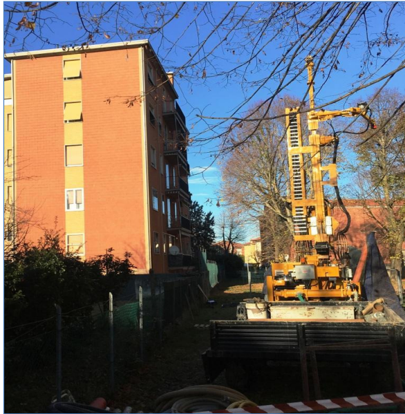
Posizionamento sondaggio DH 2
