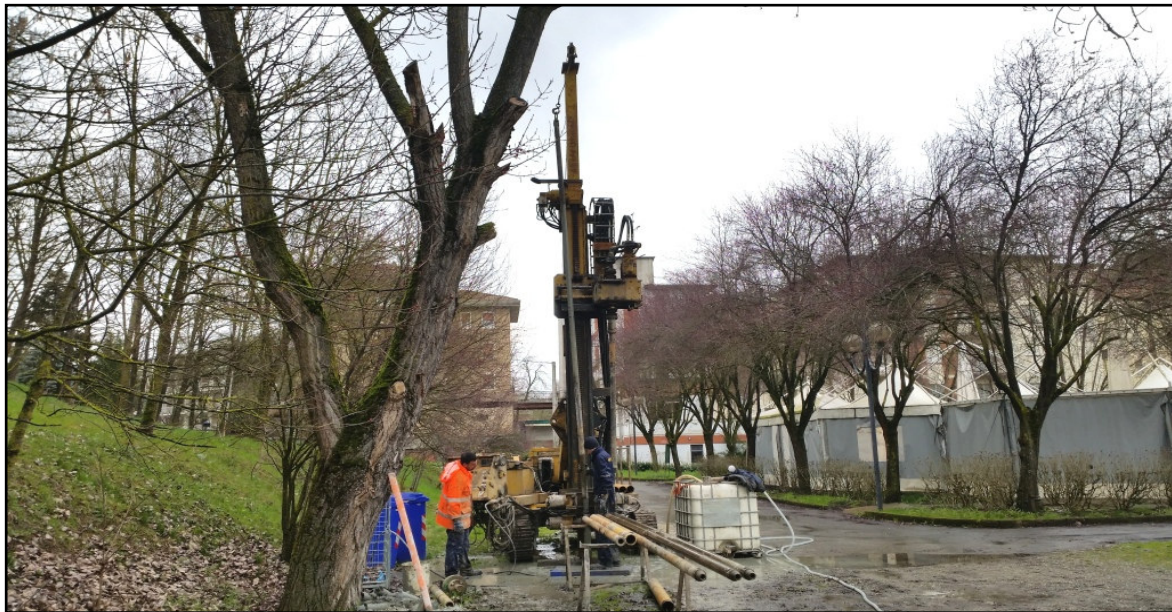
Posizionamento sonda su S1
