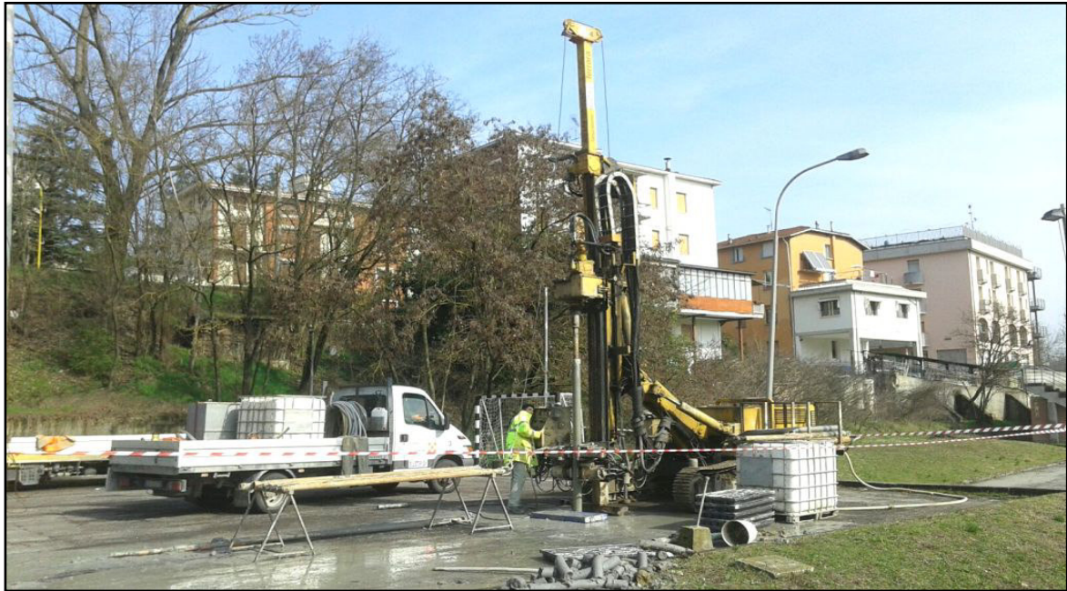
Posizionamento sonda su S2
