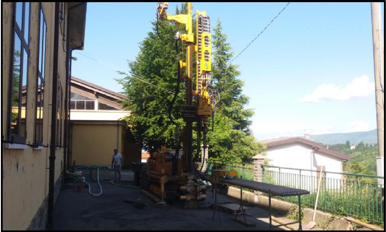
Posizionamento del sondaggio S1
