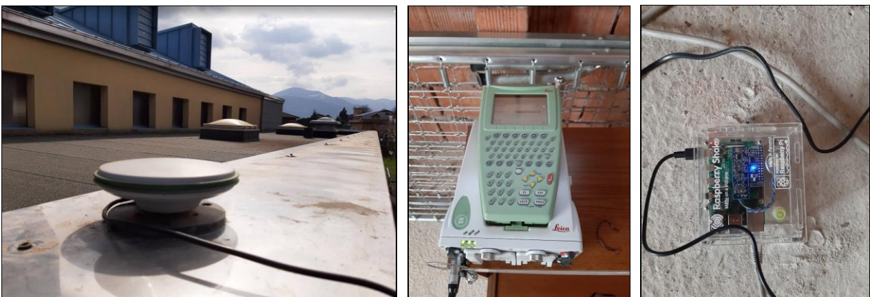
Fig. 6.3. Antenna GPS (sinistra), ricevitore Leica GPS1200 (centro) e Raspberry Shake (destra) installati a Gaggio Montano nell'edificio adiacente alla Croce Rossa
