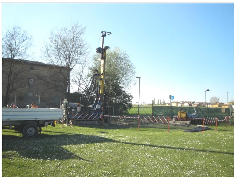
Foto 4.1 – Esecuzione del sondaggio a San Vincenzo (Campo Sportivo comunale)
