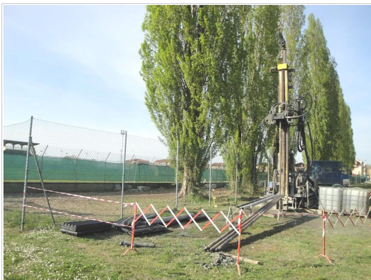
Foto 4.1 – Esecuzione del sondaggio a San Giorgio di Piano
