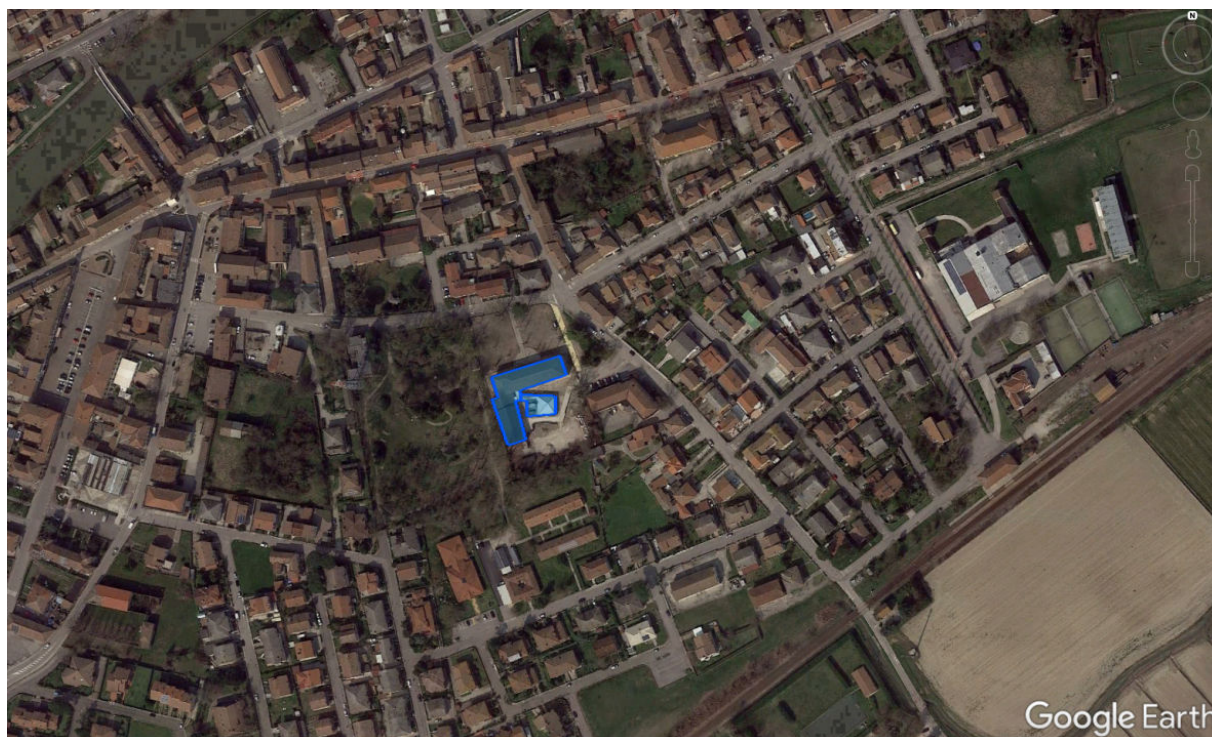
EDIFICIO STRATEGICO – SCUOLE MEDIE MIGLIARINO
