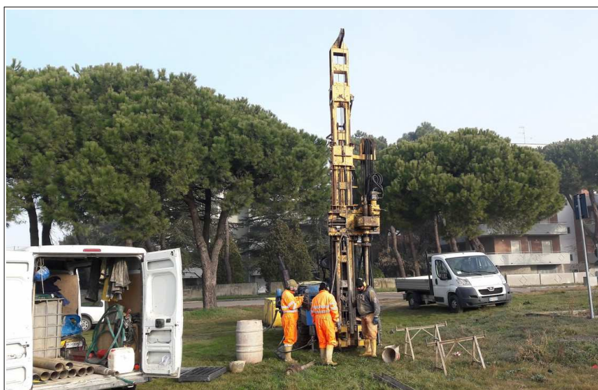
Foto 4.1 - Esecuzione del sondaggio a Pinarella di Cervia
