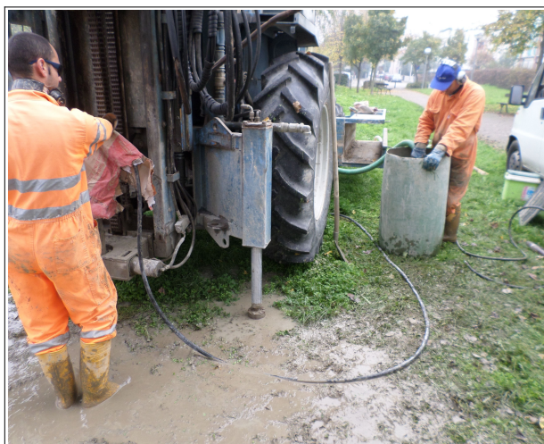
Foto 4.4 e 4.5 – Sondaggio a carotaggio continuo eseguito in Piazza Giani (a sx) e installazione tubo per “Down-Hole” (a dx).
