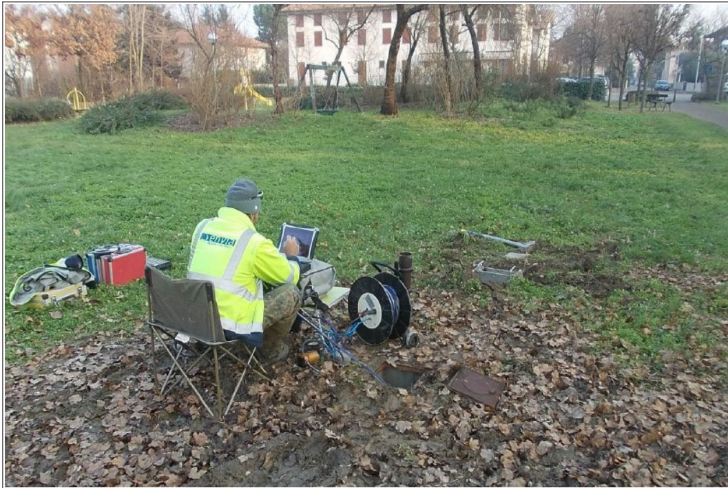
Foto 4.6 – Prova Down-Hole eseguita nel foro di sondaggio di Piazzale Giani.
