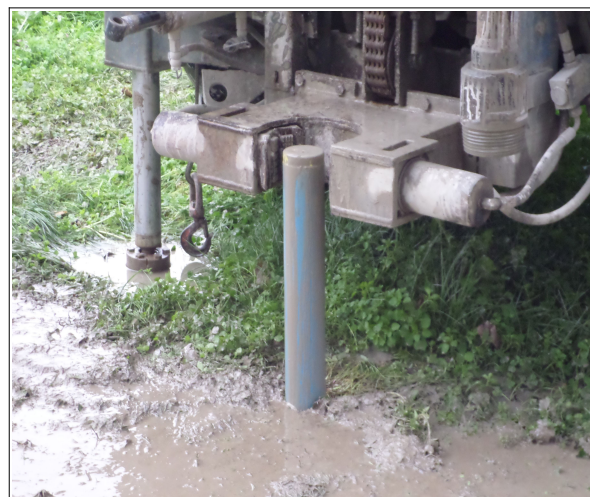
Foto 4.4 e 4.5 – Sondaggio a carotaggio continuo eseguito in Piazza Giani (a sx) e installazione tubo per “Down-Hole” (a dx).
