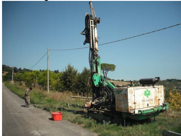
Figura 23: Sonda posizionata per l'esecuzione del sondaggio geognostico
