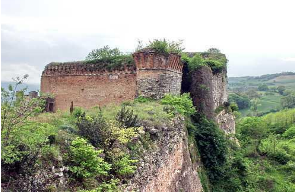
Affioramento della Formazione dello Spungone alla base della Rocca di Castrocaro.
