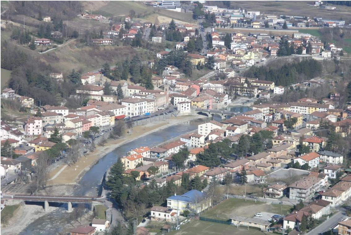
Foto 1 - veduta aerea radente del centro storico di Santa Sofia
